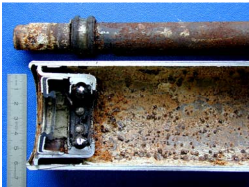
Korrosionsschaden an der Rolle eines Förderbandes
